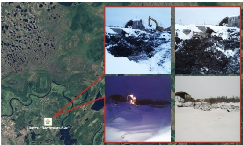
Рис. 1. Засыпка провала на территории шахты «Восточная-бис»
